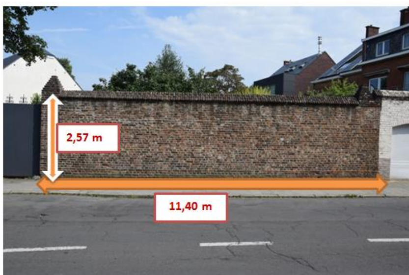
Partie droite du mur
